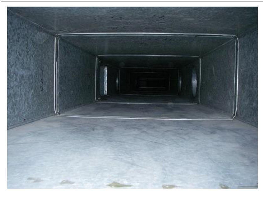
SAダクト 清掃後
