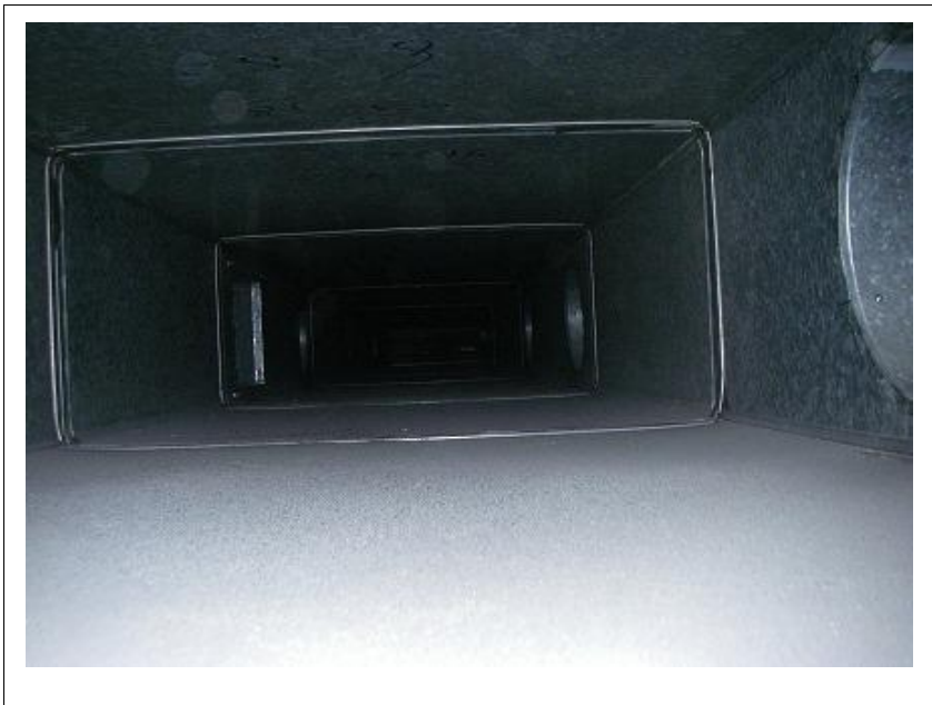
〇〇〇ビル 空調換気ダクト清掃工事 〇階系統 SAダクト 清掃前
