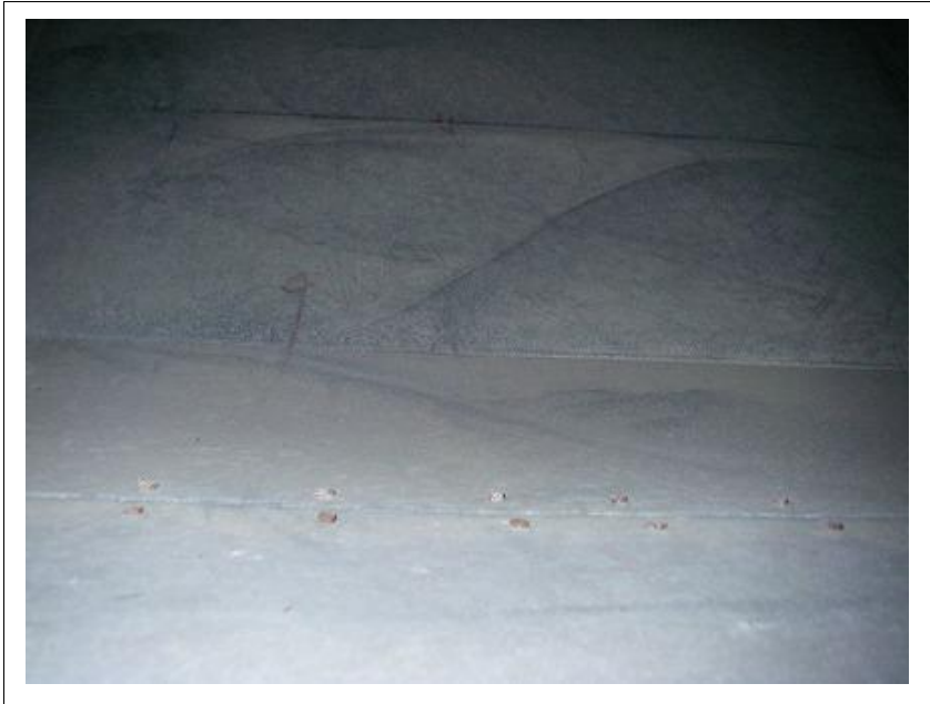
SAダクト 清掃後
