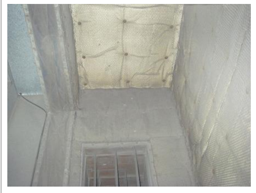
〇〇〇ビル 空調換気ダクト清掃工事 〇階系統 RAチャンバ 清掃前
