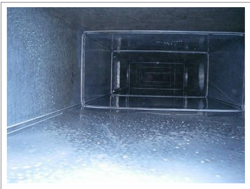
SAダクト 消毒・無機抗菌剤噴霧後
